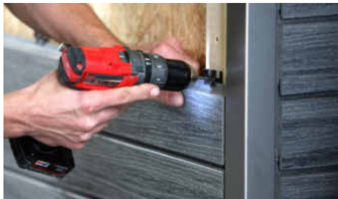
Fassadenprofile werden mit einer Nut- und Spundverbindung formschlüssig auf einer Holzunterkonstruktion angebracht.
