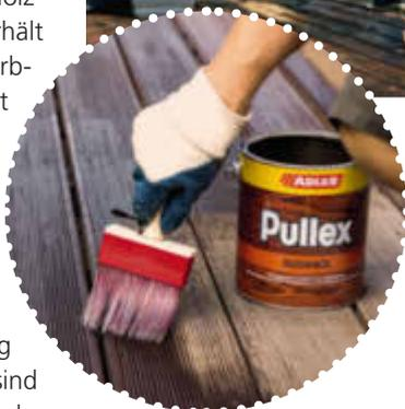
Danach die Terrasse gut mit Wasser abspülen. Einen Holzentgrauer beispielsweise von Adler unverdünnt in einen Kübel geben und satt mit einer Bodenstreichbürste auftragen. Anschließend 20 Minuten einwirken lassen. Die Holzdielen dürfen in dieser Zeit nicht austrocknen. Dann die Dielen mit viel Wasser und einer Bürste – am besten mit einer Nylonbürste – abwaschen. Nun lassen sich Algen und Schmutz leicht ent-
